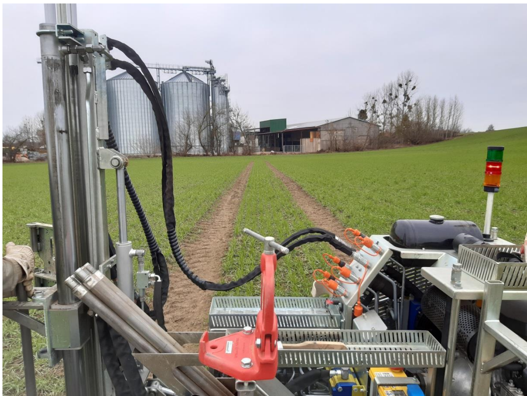
Blick über das nördliche Baufeld in westliche Richtung
